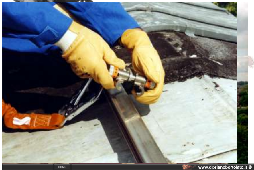
Lavoro sulla copertura
