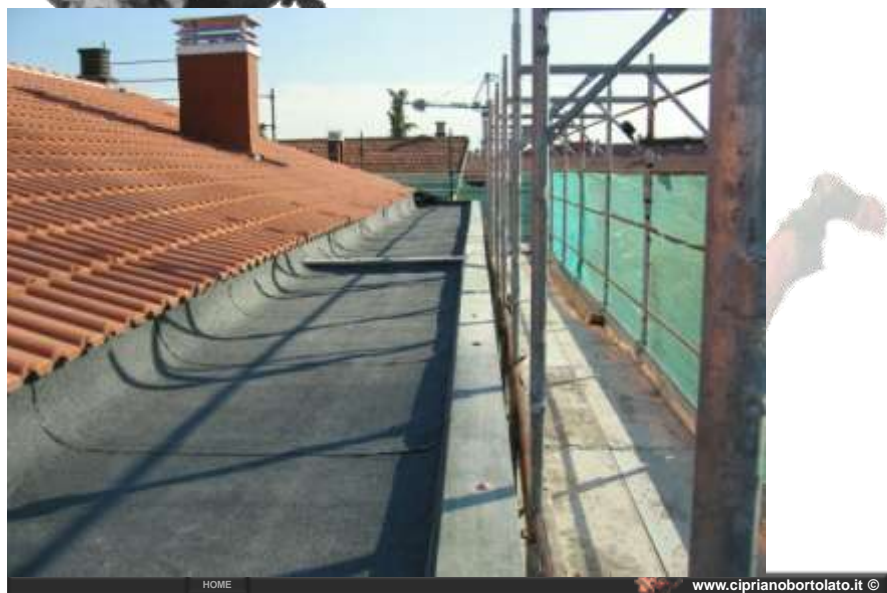
Ponteggio di protezione della copertura
