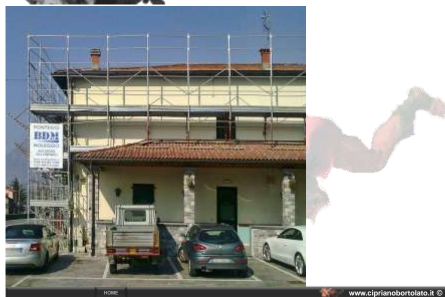
Ponteggio di protezione della copertura
