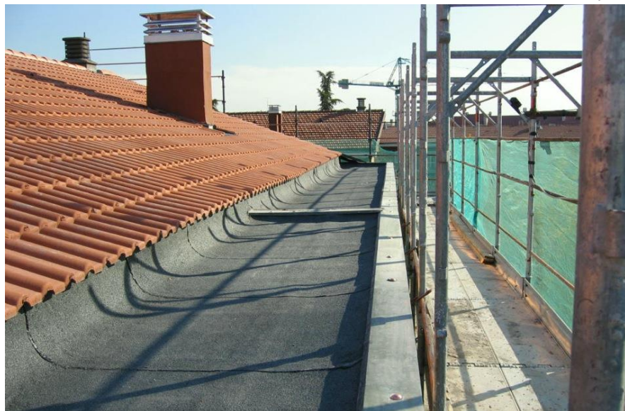
Ponteggio di protezione della copertura
