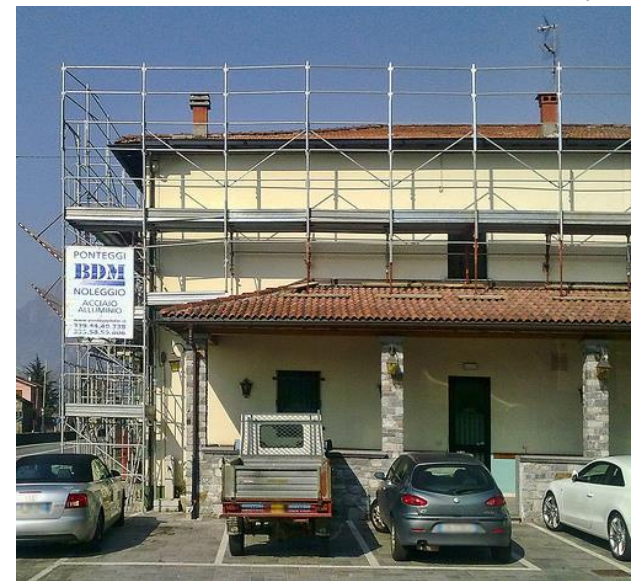
Ponteggio di protezione della copertura
