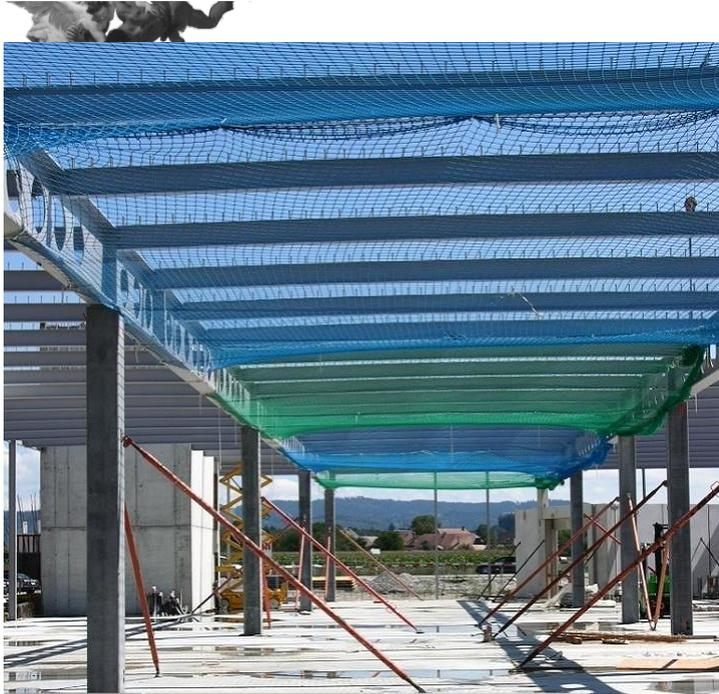
LIVELLO 4    PROTEZIONE PASSIVA    RETI DI PROTEZIONE
