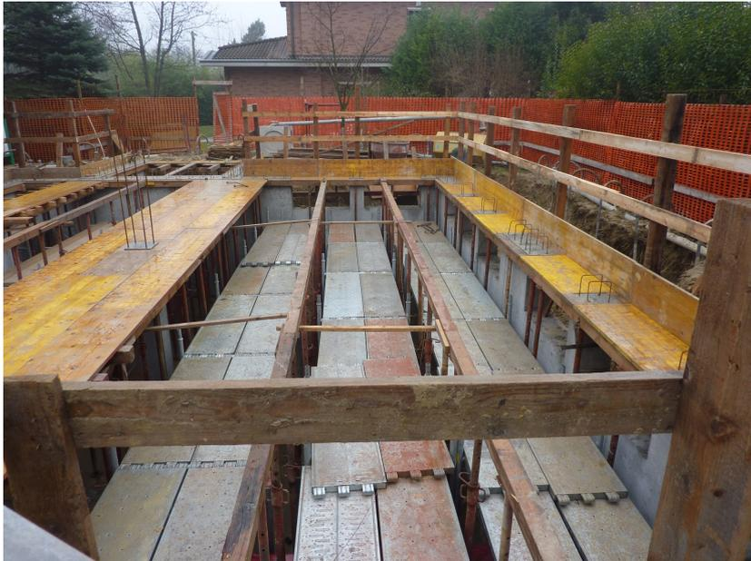
LIVELLO 4    PROTEZIONE PASSIVA    PIATTAFORME DI RACCOLTA    RIGIDE
