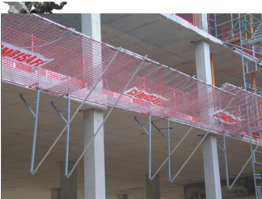
LIVELLO 4    PROTEZIONE PASSIVA    RETI DI PROTEZIONE
