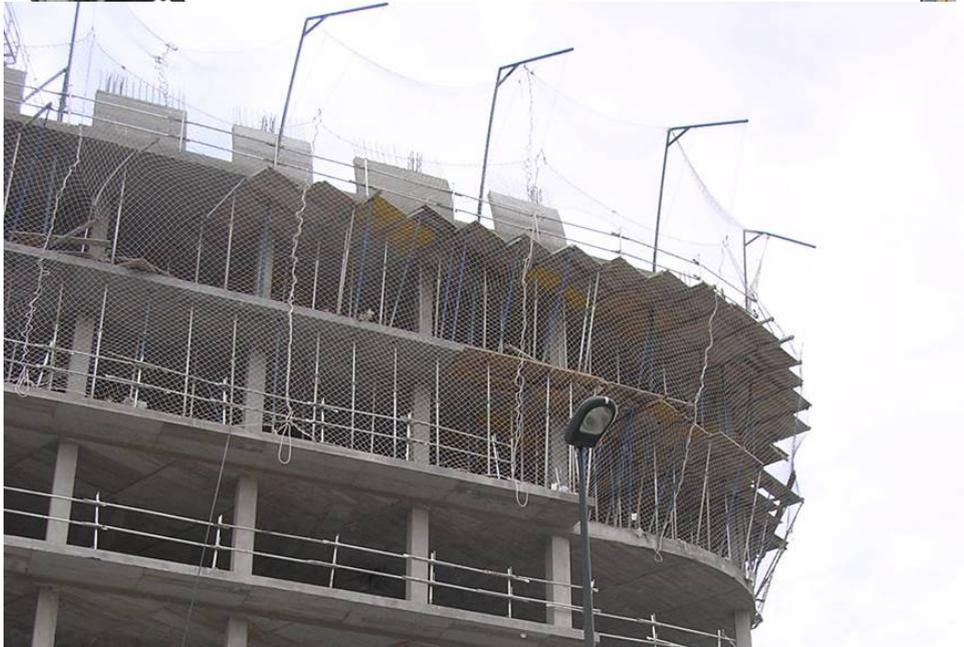
LIVELLO 4    PROTEZIONE PASSIVA    RETI DI PROTEZIONE
